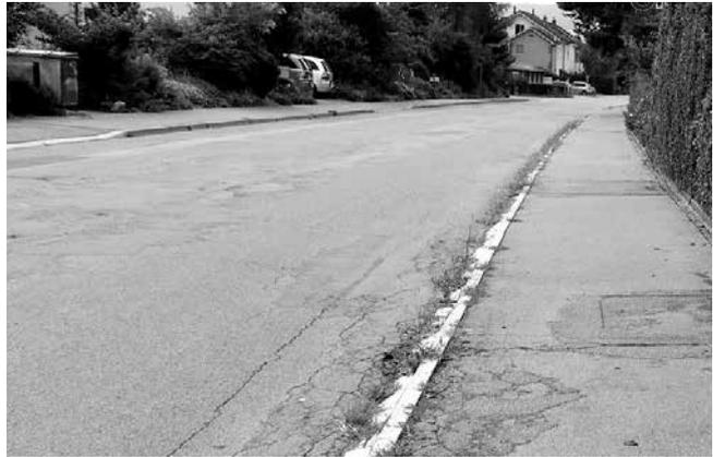
Die Stationsstrasse als ursprüngliche Kantonsstrasse wurde 1992 an die Gemeinde Hettlingen übergeben und weist Risse durch Belags- und Tragschicht auf, auch durch die diversen Werkleitungsbauten und Sanierungen. Ausserdem weisen Netzrisse im Belag auf eine ungenügende Foundationsschicht hin.
