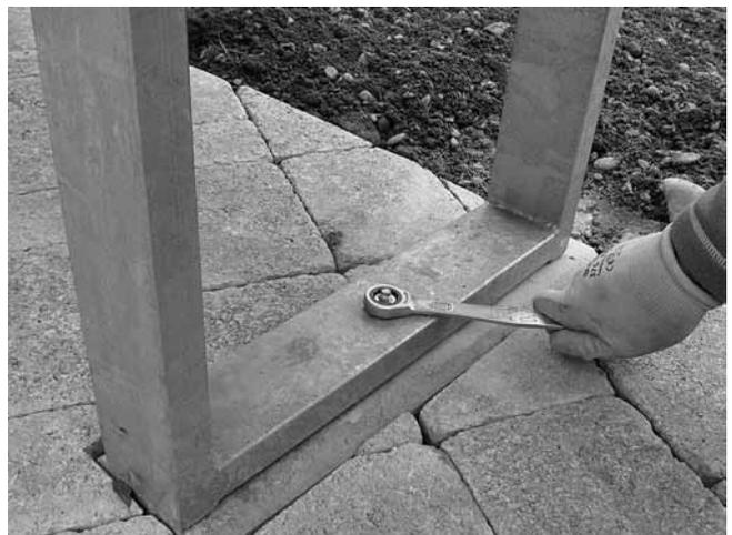
*Der starke Metallrahmen ist fest mit dem Betonfundament verschraubt.*
