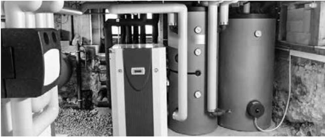
Wärmepumpen (WP) sind Anlagen, die Umweltwärme tieferer Temperatur in Heizwärme höherer Temperatur umwandeln. Sie können die Energie aus der Luft, dem Wasser oder der Erde gewinnen. Die Umwandlung erfolgt mittels Kompressor, der mit Strom betrieben ist. Eine gute WP produziert mit dem zugefügten Strom vier- bis fünfmal mehr Energie in Form von Wärme.
