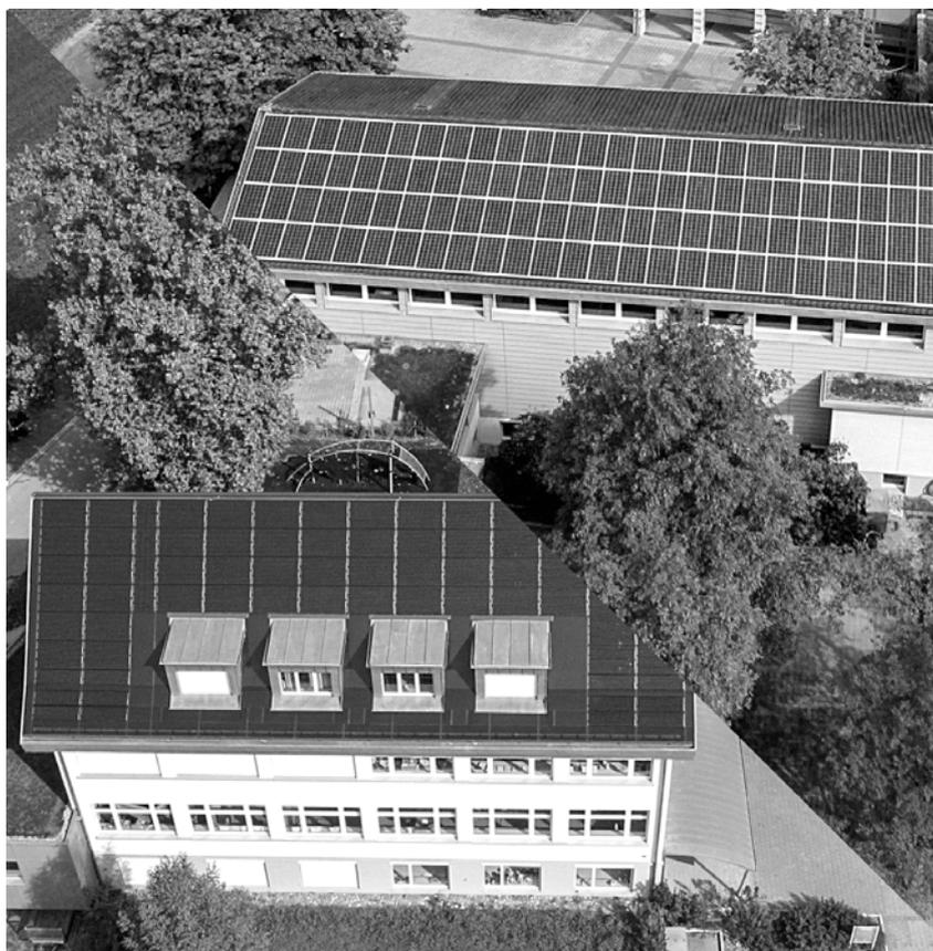
Durch den Ertrag aus der Einspeisung in das Netz der EKZ und die Minderkosten durch den Eigenverbrauch der produzierten Energie können aktuell pro Jahr ca. Fr. 6'000.– gespart werden. Dies bedeutet, dass die Photovoltaikanlagen in rund 17 Jahren, voraussichtlich im Jahr 2035, vollständig amortisiert sein werden. Da sich die Strompreise stetig verändern ist eine Abweichung möglich.
