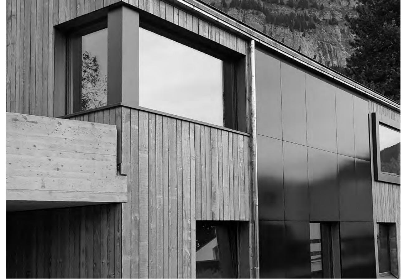
Fassaden-PV-Anlage (Bild: solpic.ch/projekte/pv-fassadenanlage).
