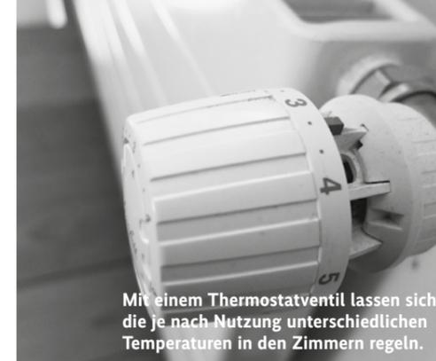
Mit einem Thermostatventil lassen sich die je nach Nutzung unterschiedlichen Temperaturen in den Zimmern regeln.
