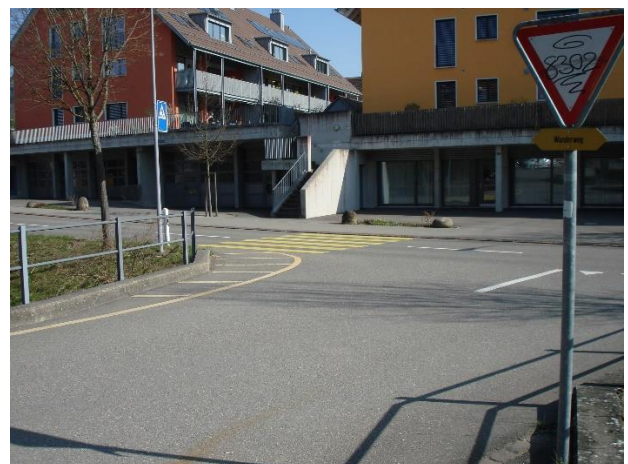
Abbildung 14: Brücke Blick Richtung Schaffhauserstrasse
