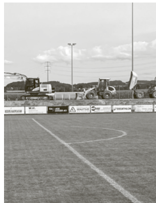
Baumaschinen im Einsatz.
