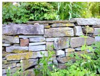
Mauern mit Fugen bieten Lebensraum für spezialisierte Pflanzen und zahlreiche Kleintiere.
