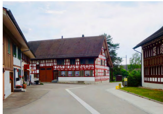
Eingang Dorfkern, Stationsstrasse Nr. 23, Blickrichtung Südwesten
