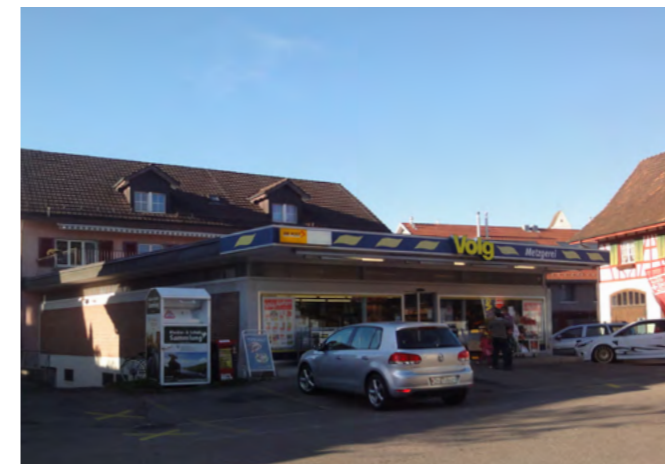
3) Volg-Filiale, Stationsstrasse Ecke Schulstrasse
