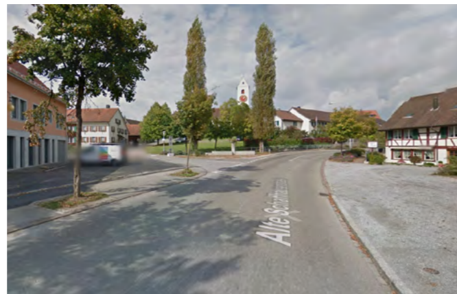
2) Schaffhauserstrasse, Teilbereich "Sonne"
