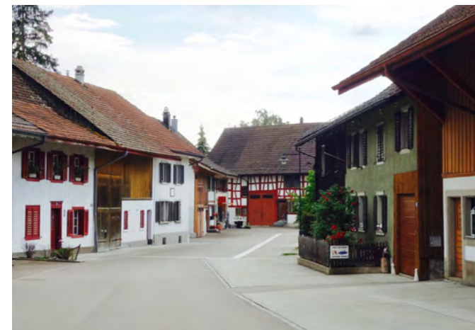
Stationsstrasse, Südwestlicher Teil
