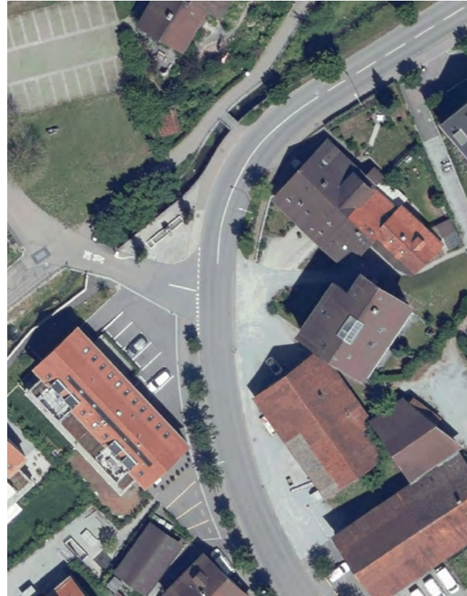
2) Schaffhauserstrasse, Teilbereich "Sonne"
