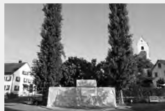
Der Brunnen «Schaffhauserstrasse/Kirchsteig» im Sanierungsmodus.
