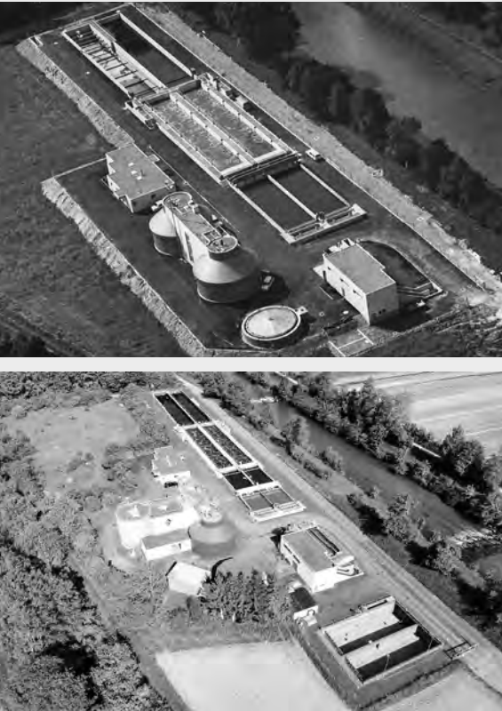
Oben: Kläranlage Pfungen bei der Inbetriebsetzung 1973. Unten: Kläranlage Pfungen 2023.
