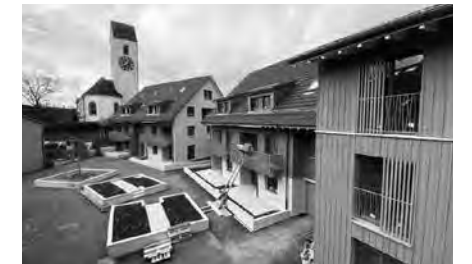
Für die Überbauung Wiesenbach realisierte EKZ Eltop die Elektroinstallationen.
